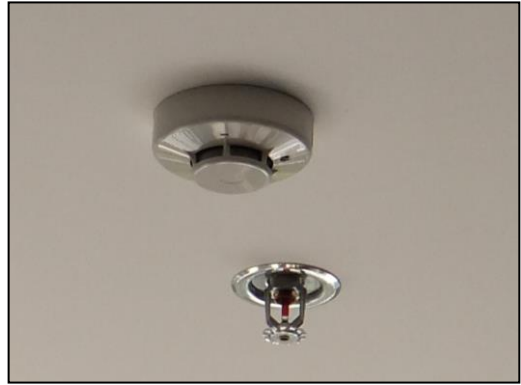
ภาพที่ 2-8 Smoke Detector & Sprinkler
