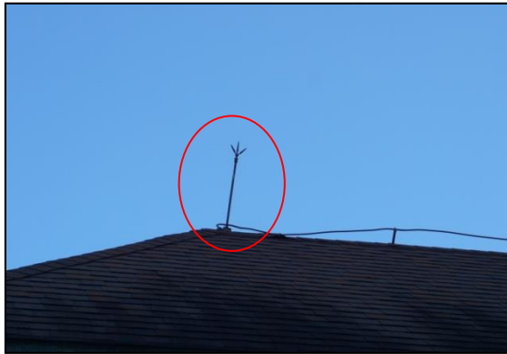
ภาพที่ 1-18 เสาล่อฟ้า
